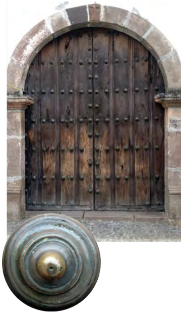
15. Ejemplos de buelas o chapelones en la herrería colimense en Nogueras, Comala, Colima.
