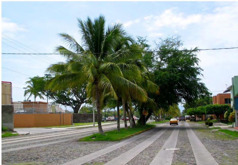
Fotografía 3. Avenida Constitución, empedrada y con huellas de rodamiento de concreto.
